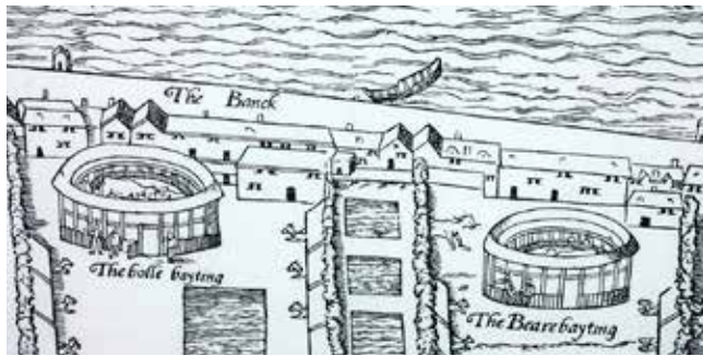
左側に見えるのが「ブル・ベイトイング」の円形闘技場。右側の円形闘技場で「ベア・ベイトイング」が行われていた。
