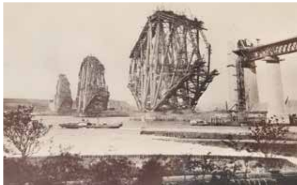
建設途中のフォース・ブリッジ。3基を同時進行で造っていったことが分かる。
