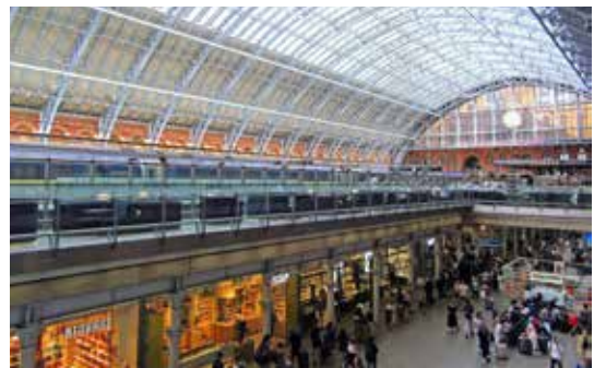
プラットホームは、地上から5メートルの位置にある。かつてビール樽が積まれていた地上階はショッピング・モールに様変わりしているが、各店舗をよく見ると、レンガ造りのアーチ型倉庫の面影が残る。
