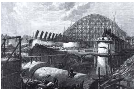
建設中のセント・パンクラス駅。
