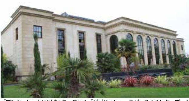
「マンション」とは別棟となっている「パビリオン」。スパ、スイミング・プールなどの施設が設けられている。
