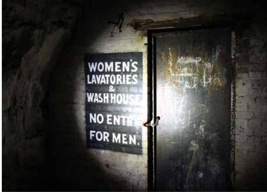
戦時中に使われていた、女性専用のトイレと水場。水場では身体や髪を洗ったり、洗濯したりしていた。「NO ENTRY FOR MAN.」と書いてあるのが面白い。
